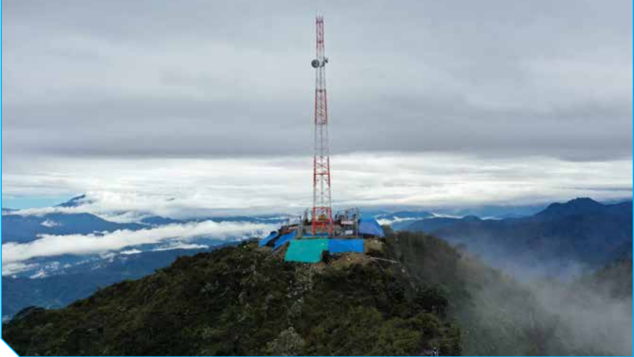
Pembangunan menara telekomunikasi di Puncak Jaya, Papua Telecommunication tower construction in Puncak Jaya, Papua
